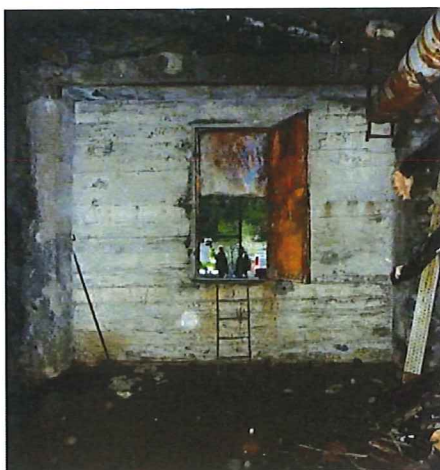
Photo DPSM, porte vue depuis l'intérieur de la galerie 1230.
